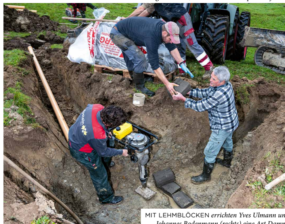
YVES ULMANN (rechts) und ein Mitarbeiter graben dort, wo sich die Wasserquelle befindet.
